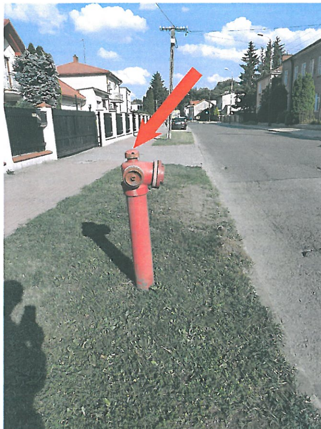
Reper roboczy nr 7 - najwyższy punkt hydrantu po stronie lewej około km 0+924 H=104.12
