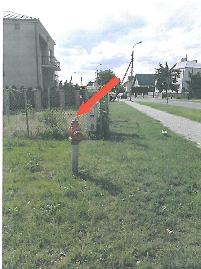
Reper roboczy nr 1 - najwyższy punkt hydrantu po stronie prawej około km 0+357 H=103.41
