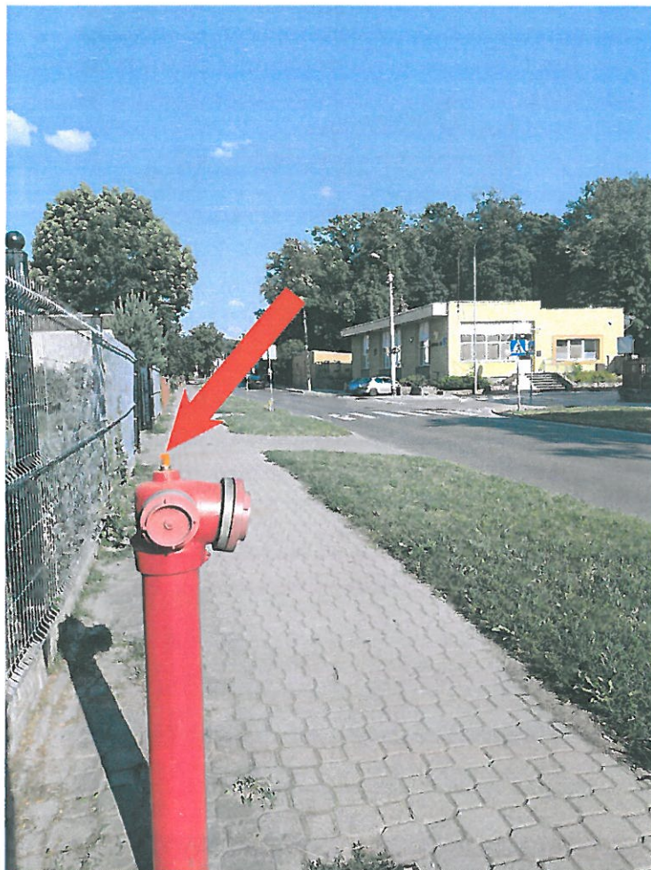
Reper roboczy nr 9 - najwyższy punkt hydrantu po stronie lewej około km 1+107 H=105.49
